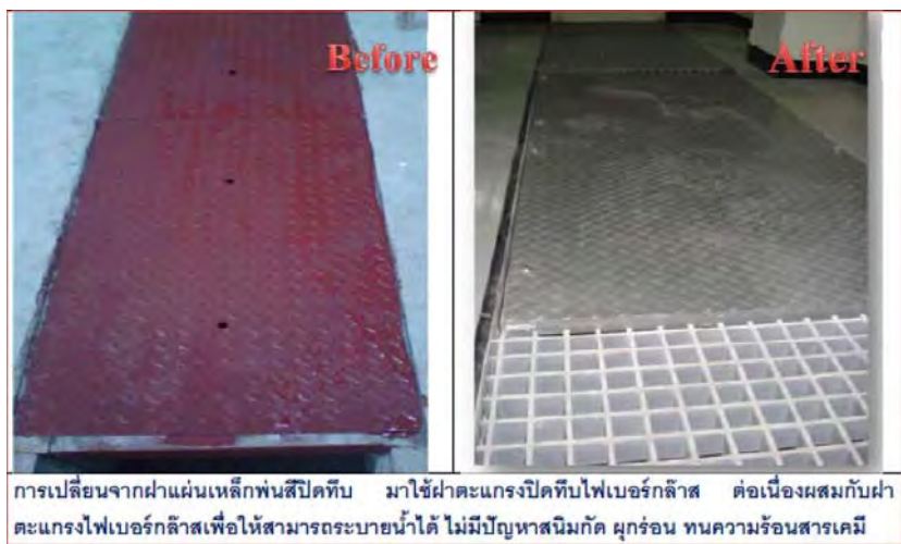
การประยุกต์ติดตั้ง ติดตั้ง ทำฝาปิดที่ระบายน้ำในส่วนของสำนักงานโรงงาน โดยใช้ตะแกรงไฟเบอร์กลาสปิดทับด้วยแผ่นพลาสติก ยึดด้วย stainless steel M-clip
