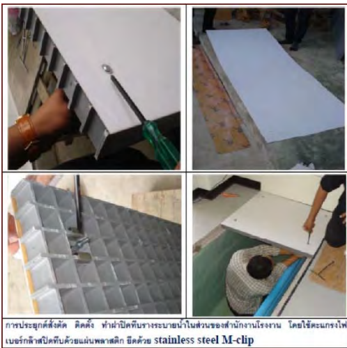
การเปลี่ยนจากฝาแผ่นเหล็กพื้นสีปิดทึบ มาใช้ฝาตะแกรงปิดทึบไฟเบอร์กลาส ต่อเนื่องผสมกับฝาตะแกรงไฟเบอร์กลาสเพื่อให้สามารถระบายน้ำได้ ไม่มีปัญหาสนิมกัด ยุกร้อน ทนความร้อนสารเคมี
