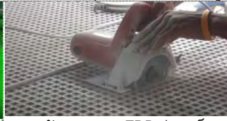
การตัดตะแกรง FRP ง่าย เร็ว
